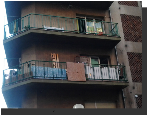
Acumulació de matalassos als balcons
